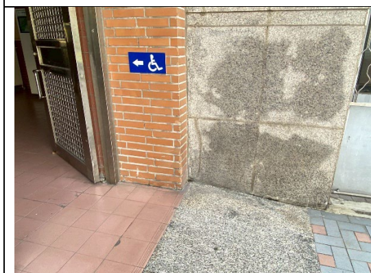
互助大樓室外通路
