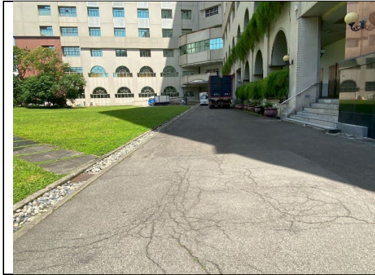
通往立夫教學大樓室外無障礙通路
