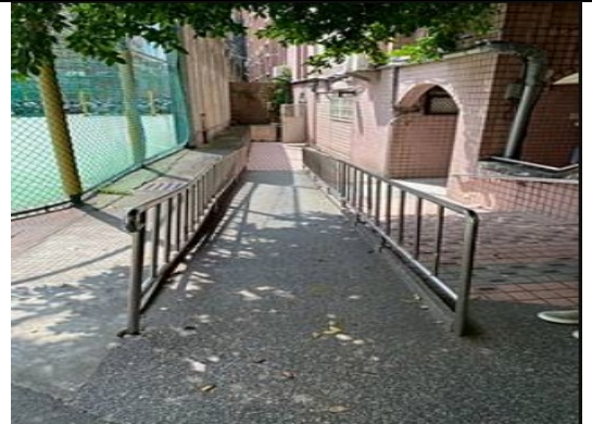
球場旁室外無障礙通路
