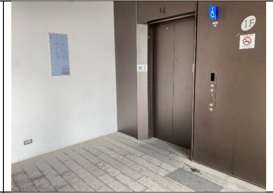
關懷大樓無障礙電梯
