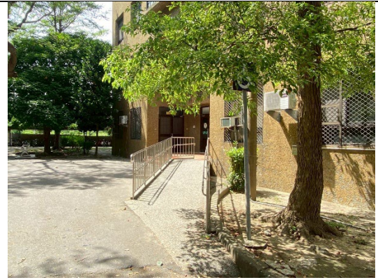
通往宿舍無障礙斜坡道
